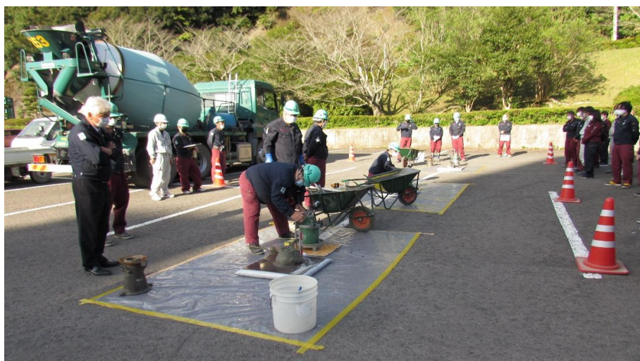
生コン製品の 受入検査の様子
