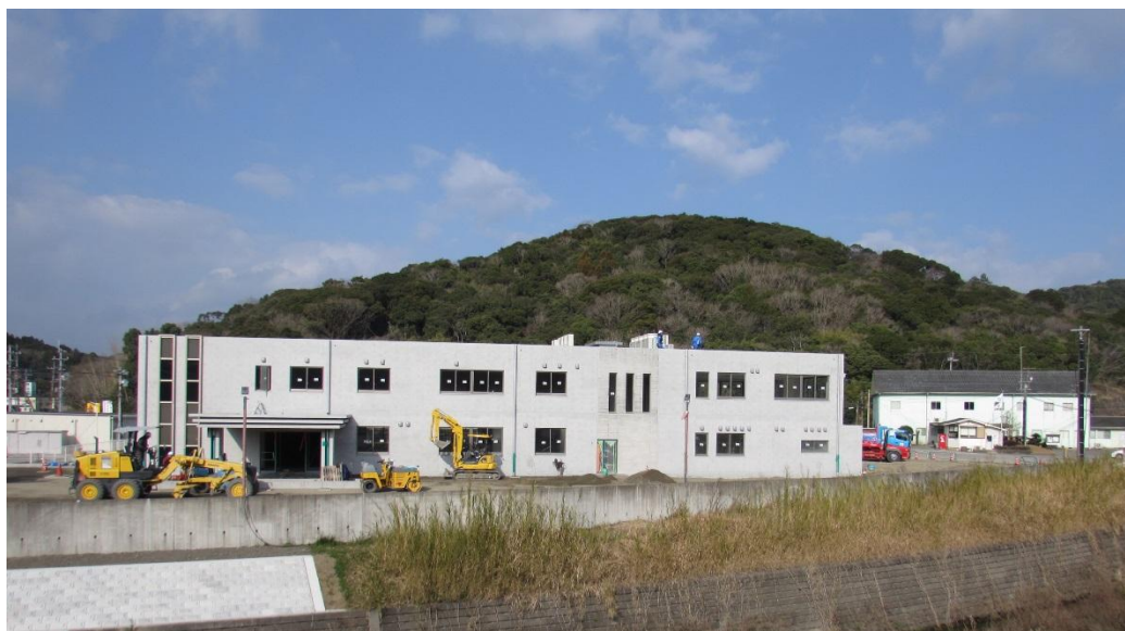
足場が外れ姿を見せた 新社屋の外観
