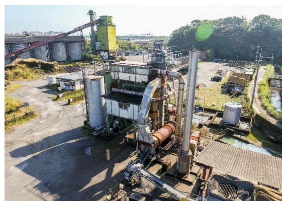
大隅工場 (生コンプラントは解体されて今はありません。)
