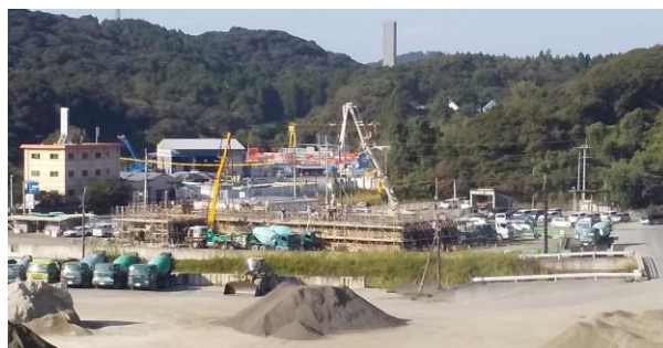
11月の新社屋生コン打設の様子 (岩元工場から撮影)
